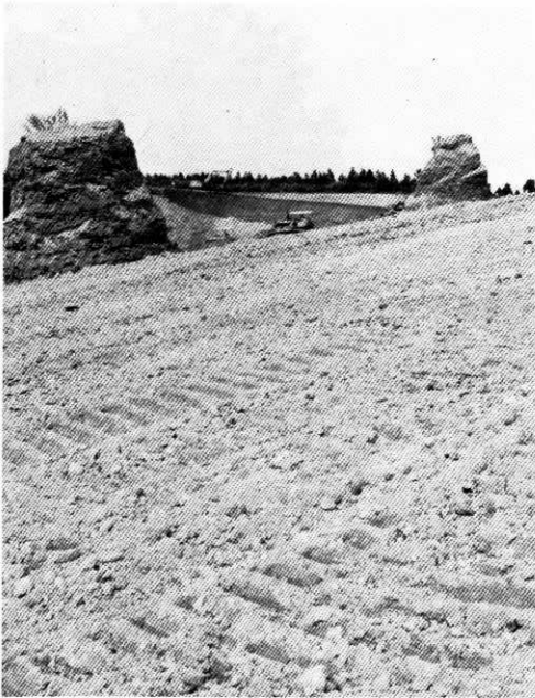
造成が進む源右エ門団地
