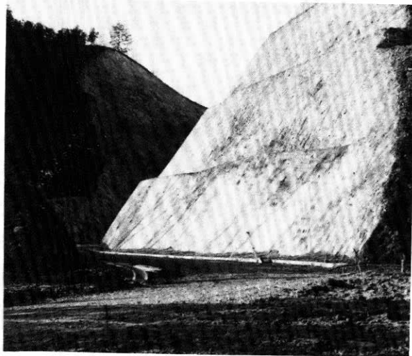
改良工事が完了した葛黒・吉ヶ沢線
