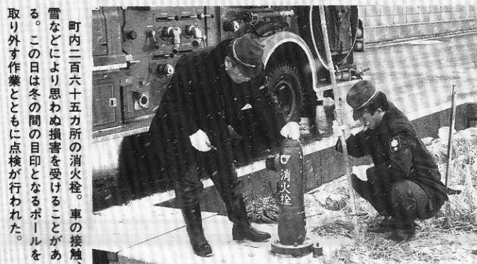
町内二百六十五カ所の消火栓。車の接触、雪などにより思わず損傷を受けることがある。この日は冬の間の目印となるボールを取り外す作業とともに点検が行われた。
