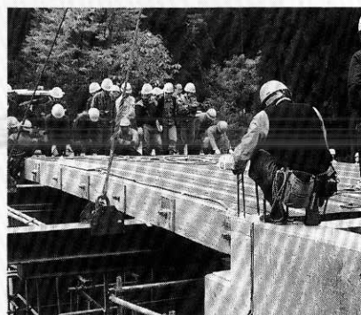
▲国内初の工法で設置された木床板
