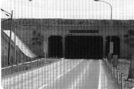
△ アクセス道路南北線ルートとなる空港滑走路の地下道(延長：500メートルのカルバートボックス)も開通しました。
