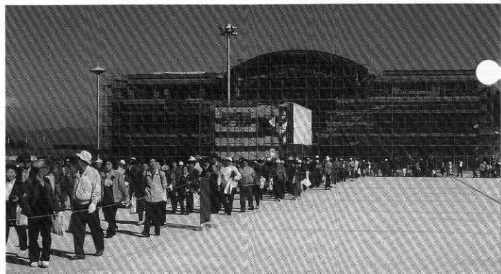
▲建設中のターミナルビルをバックにエプロンを歩いて滑走路へ
