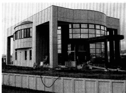
建設中の鷹巣浄化センター
