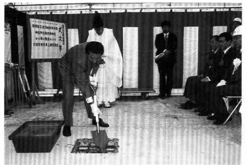
コンクリート投入の儀を行う岩川町長
