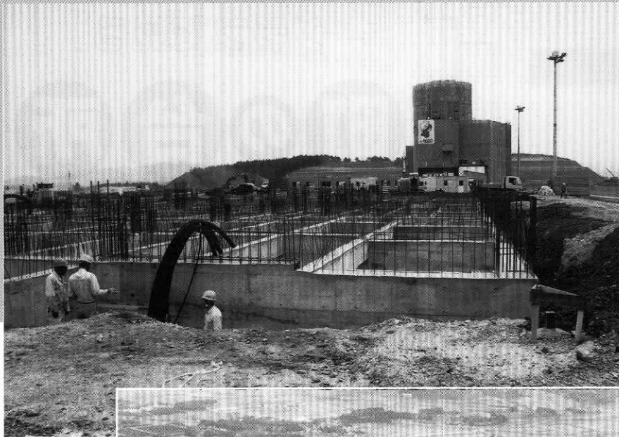
◀ 空港ターミナルビルの基礎工事。 管制塔を向こうに見ながら、 工事は順調に進んでいます。
