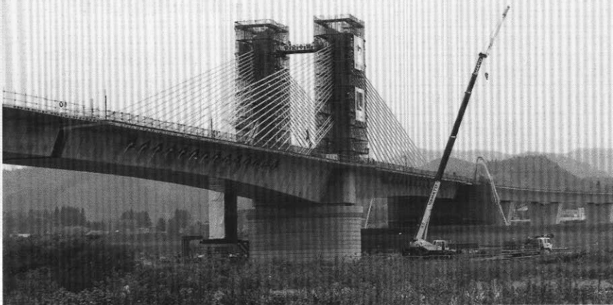
▲ 全長380メートルの翔鷹大橋 しょうよう （愛称＝たかのすスカイブリッジ）は、その特徴である外に張り出したケーブルが周囲の目を引いています。
