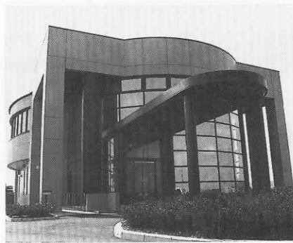
公共下水道整備（浄化センター）
