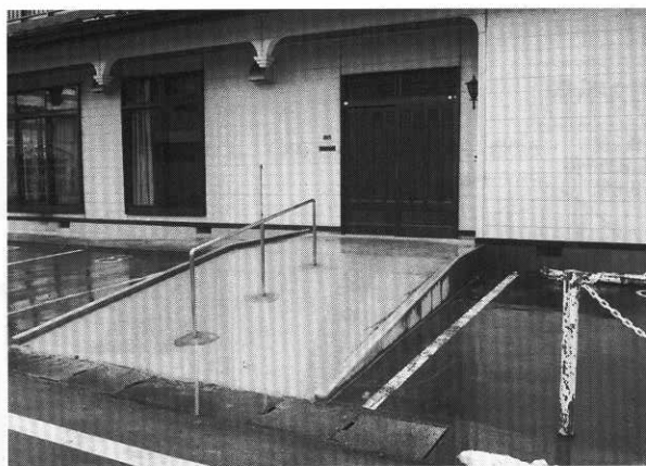
玄関にはスロープがつけられています
