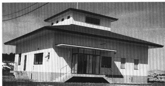
鷹巣町脇神地区農業集落排水施設
