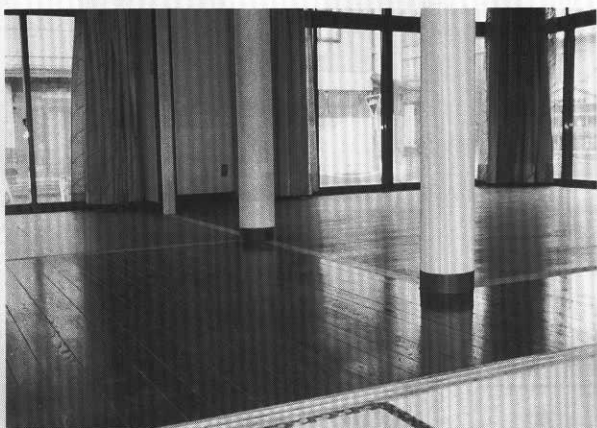
部屋の敷居の段差が解消されました
