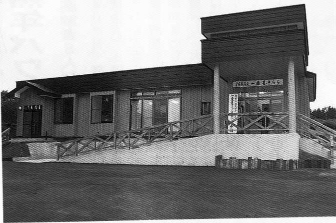
完成したケアハウス「一番星 きらら」
