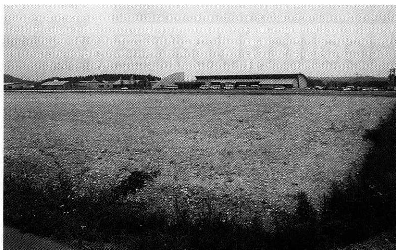
▲ 2期工事の予定現場
