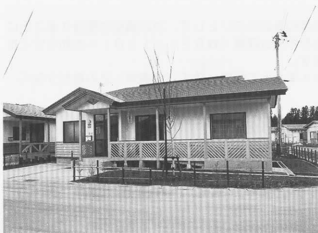
木造平屋の高野尻町営住宅のようす
