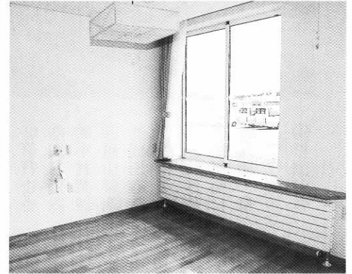
●パネルヒーターと緊急呼び出しボタン
