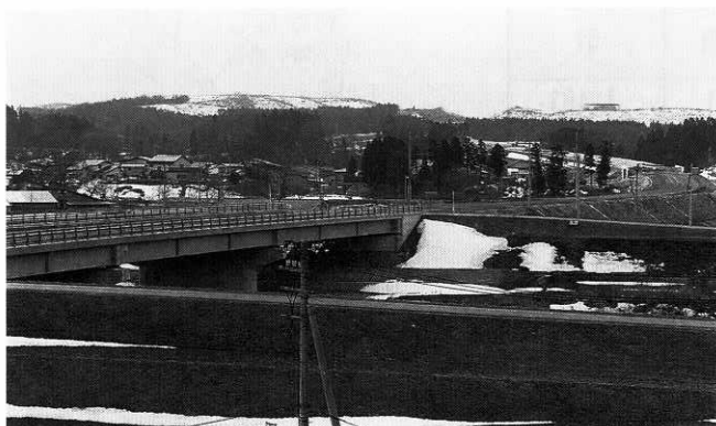
15年度完成に向け工事が始まっています
