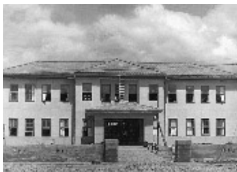
▲大館への移転問題をめぐって揺れ動いた当時の北秋田地方事務所。結局同じ場所（今の郵便局の隣り）に再建されることが決まり、昭和26年6月に庁舎が新築・落成した。
