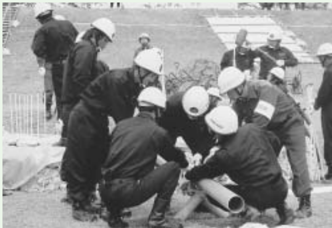
迅速な動きで月の輪工を完成させる鷹巣町水防団
