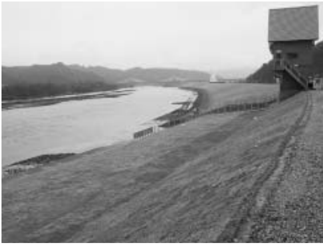
このほど完成した米代川堤防と水門
