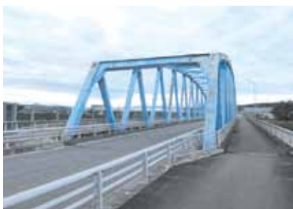
撤去が検討される米内沢橋
