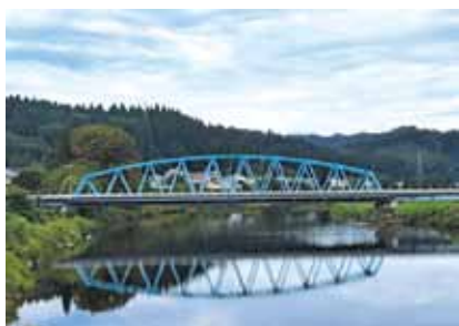
撤去検討の米内沢橋
