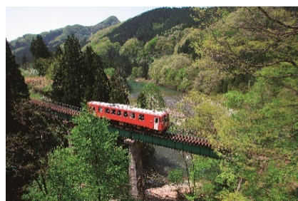
③荒瀬川橋梁（阿仁合～荒瀬）
