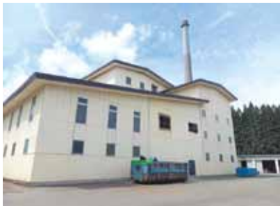
解体する旧クリーンリサイクルセンター
