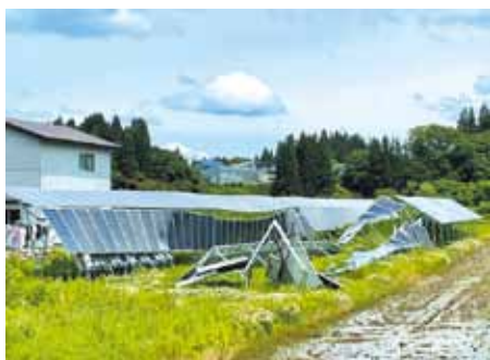
太陽光パネル設備の破損事例 (県内)
