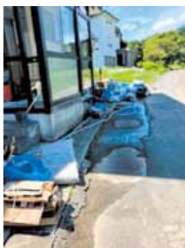
被災後、消毒無く片付け
