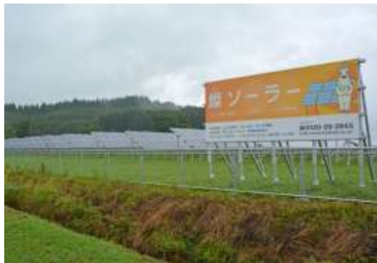
図 燦ソーラー発電所 出典：北秋田市 HP
