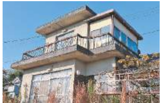
放置された空き家
