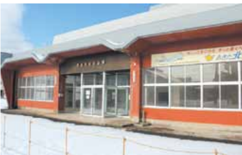
解体予定の産業会館
