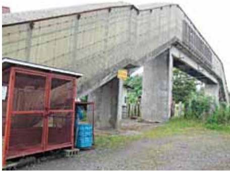
令和2年に解体された元町跨線橋
