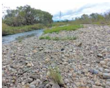
川岸に堆積する大量の土砂
