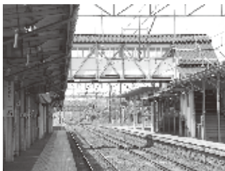
鷹ノ巣駅内の跨線橋
