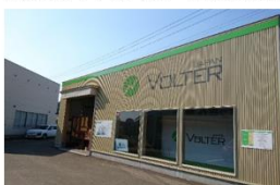
⑤木質バイオマス発電施設 H29年度
