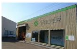
⑤木質バイオマス発電施設 H29 年度
