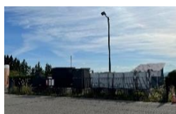
⑥防災拠点設備 H23 年度 （貯水槽・非常用発電機）
