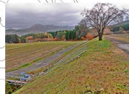
堤体下流側全景
