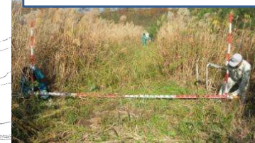
調節池(奥小ヶ田第一堤)堤体
