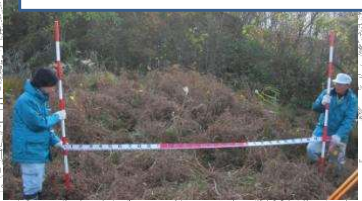
調節池(奥小ヶ田第二堤)堤体
