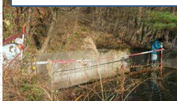
調節池(奥小ヶ田第二堤)洪水吐
