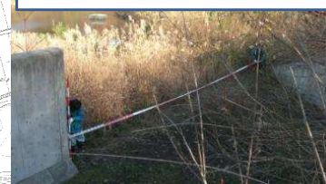
調節池(奥小ヶ田第一堤)洪水吐
