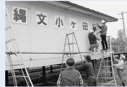
▲看板設置作業
