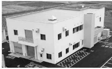
し尿処理施設は4月1日の稼働に向け準備を進めています
