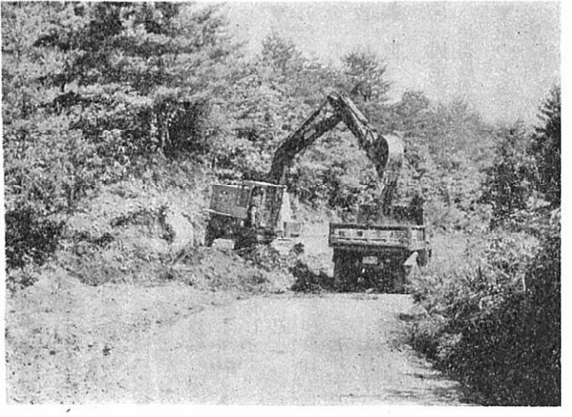
(改良工事が急ピッチに進められている黒沢地区)
