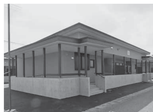
建て替えが進む南鷹巣団地
