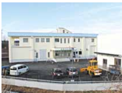
新設される鷹巣浄水場
