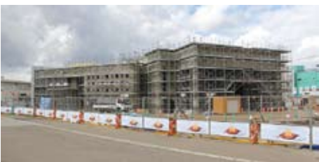
建設中の生涯学習交流施設 (市民ふれあいプラザ)
