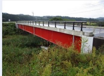
主な部材が鉄で造られた橋である。支間長の長い橋に適している。
