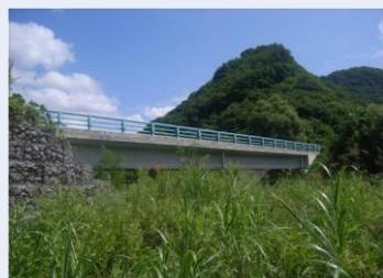
PC 橋とはプレストレストコンクリート製の橋である。
