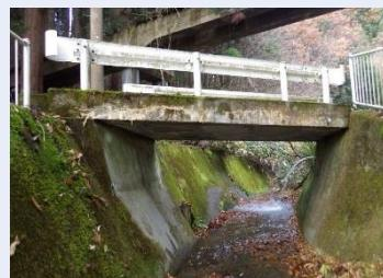
RC 橋は鉄筋コンクリート製の橋である。支間長の短い橋に用いる。
