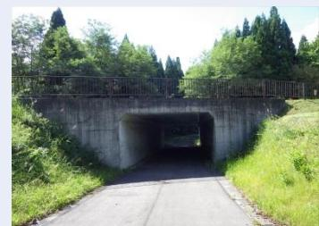
箱型の鉄筋コンクリートの構造物。比較的小規模のものが多い。
