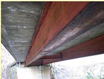
主桁の腐食
