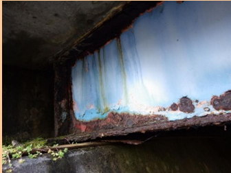
主桁の腐食
