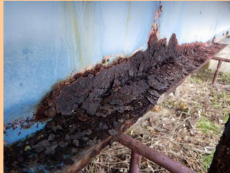
主桁の腐食
