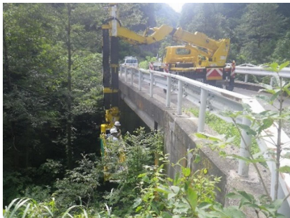
点検車による点検状況
