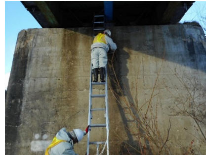
はしごによる点検状況
