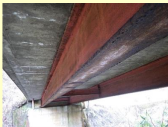
主桁の腐食
