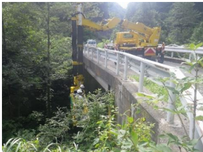
点検車による点検状況
