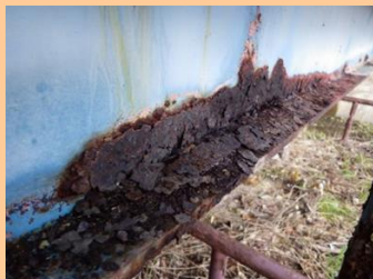
主桁の腐食
