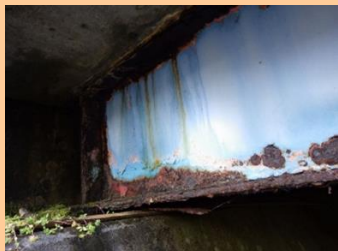
主桁の腐食
