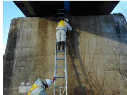
はしごによる点検状況
