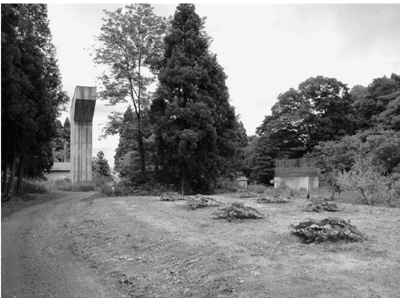
写真89 遺跡西側 旧道路橋脚
