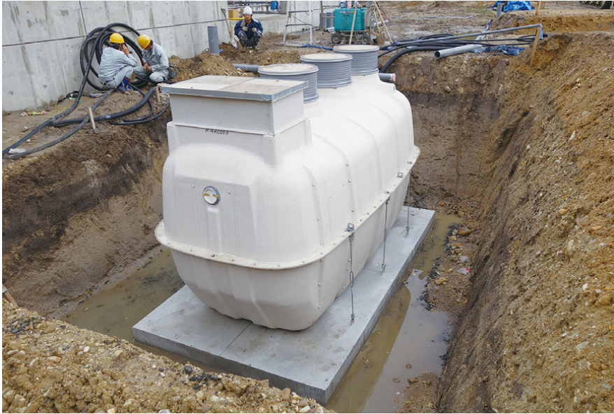
防火水槽設置
