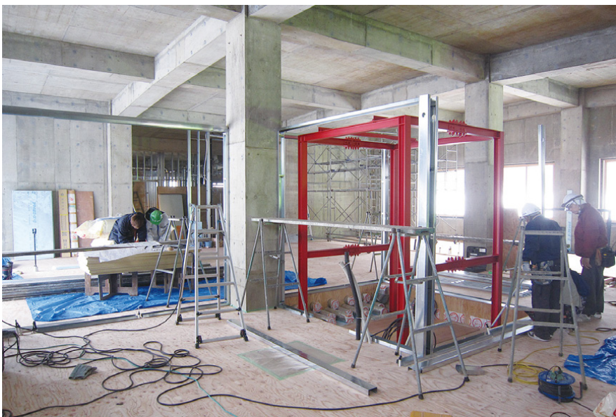
建築基礎工事
