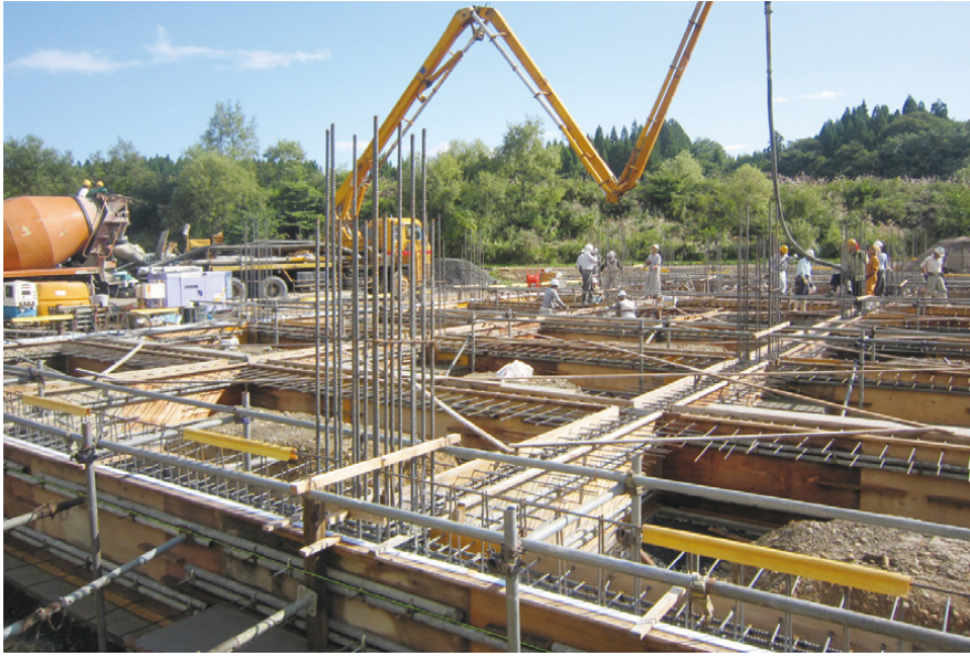
建築基礎工事
