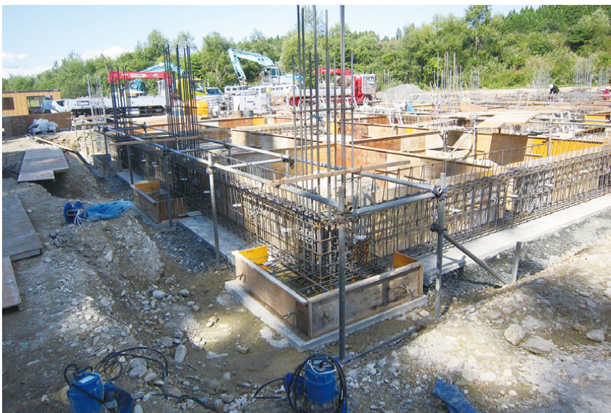
建築基礎工事
