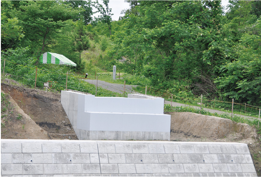
橋梁下部完成
