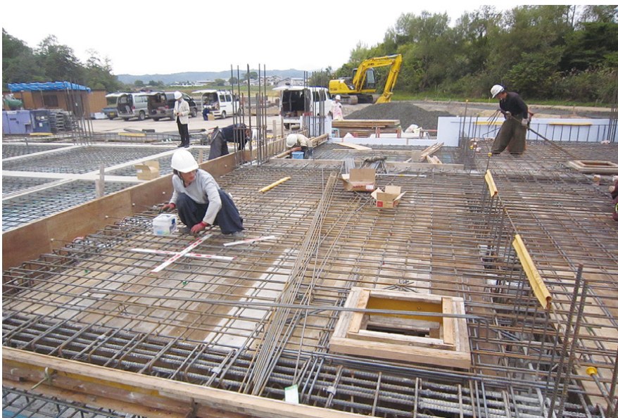
階床基礎工事
