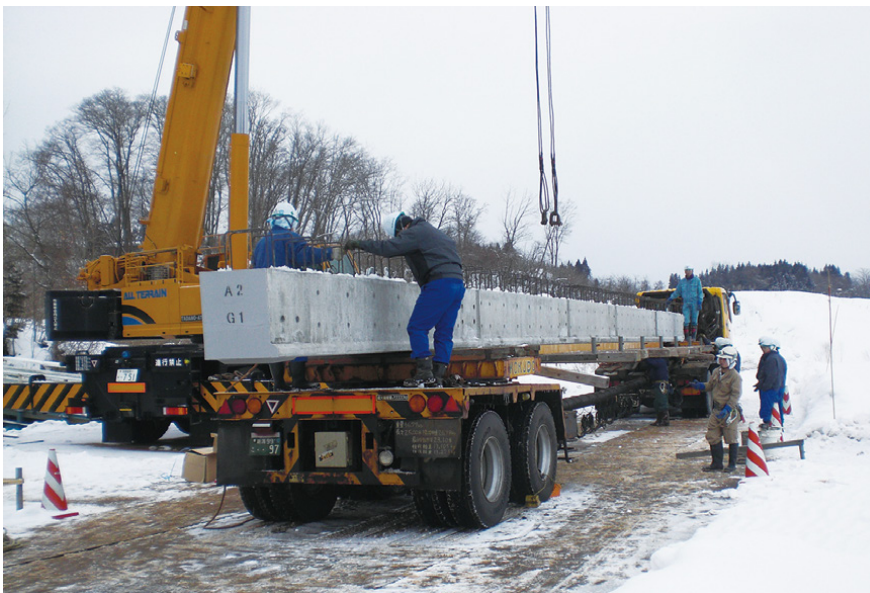
橋梁本体搬入
