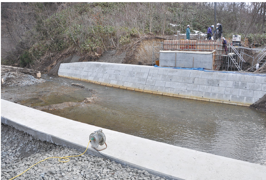
橋梁下部工事
