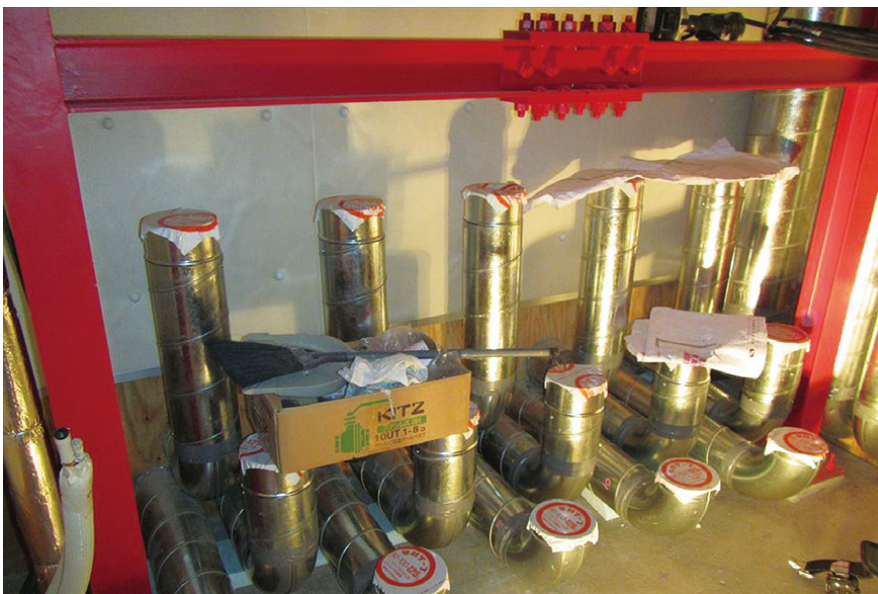
建築床下ダクト
