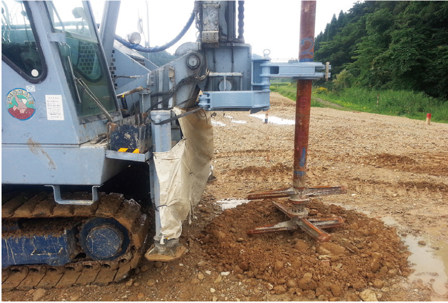
ガイダンス施設建築杭工事
