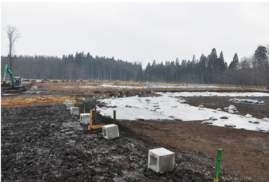
史跡盛土工事
