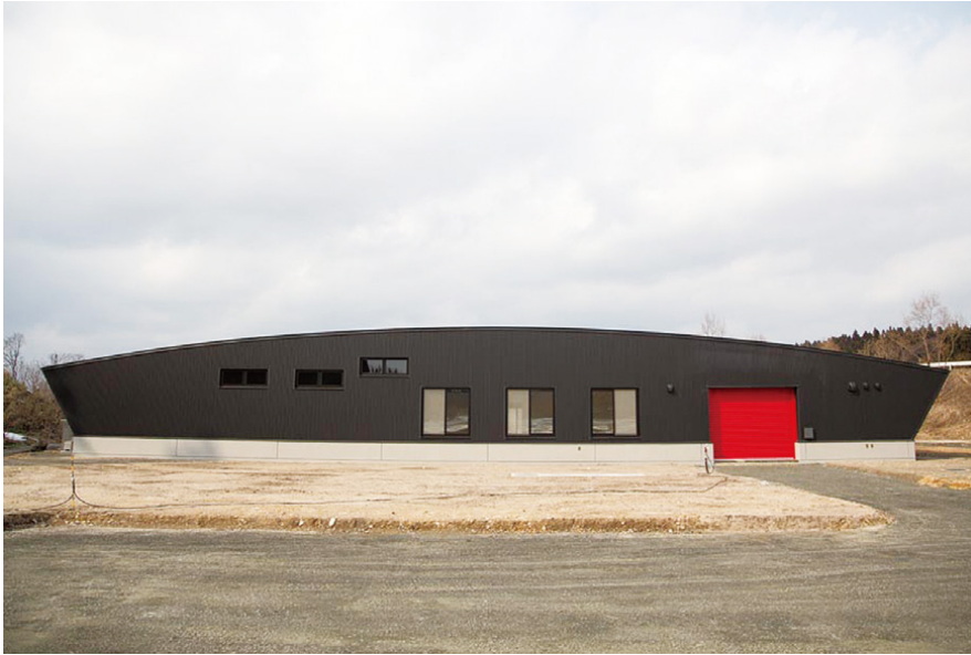
建築外観完成(南側)
