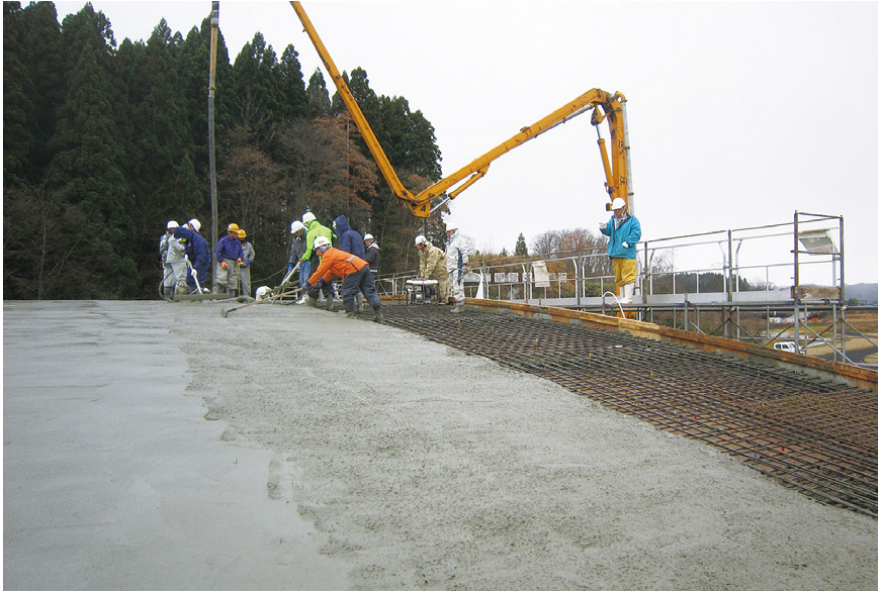
建築屋根スラブ
