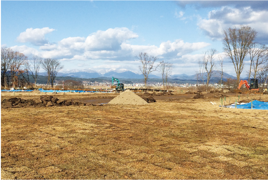
環状列石周辺張芝工事
