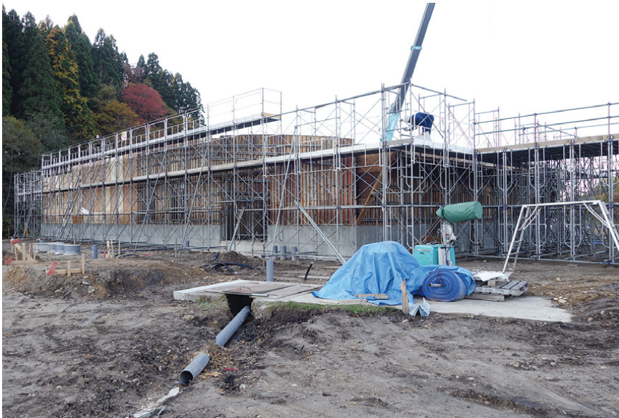
建築壁立ち上がり
