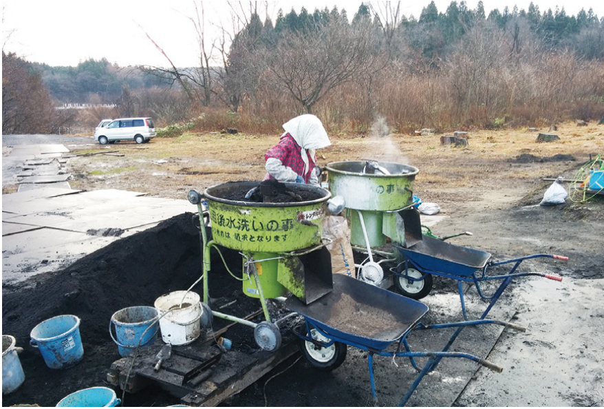
固定土攪拌作業
