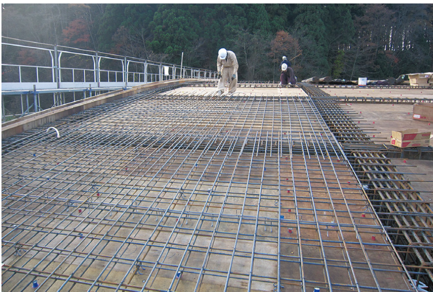
建築屋根スラブ
