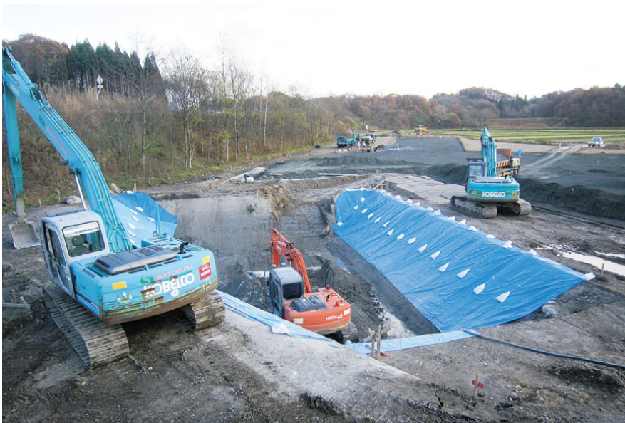
防火水槽掘削・地盤改良工事
