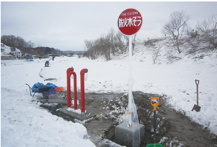
防火水槽設置完了
