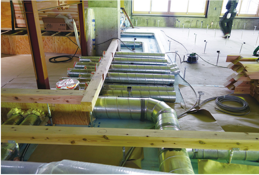
建築床下ダクト
