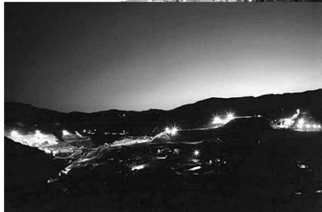
昭和47年7月の大洪水を契機に計画された森吉山ダムは、中央コア型ロックフィルダムという形式で作られており、建設に必要な岩石の量はダンプカー約120万台分で、総貯水量は東京ドーム約63杯分にもなります。
