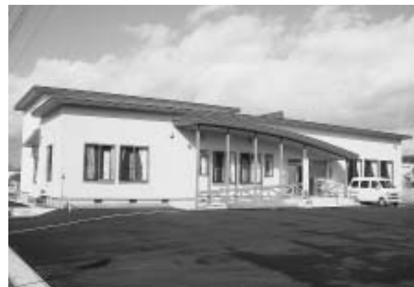
鷹巣中央小学校の隣接地に建設された鷹巣中央児童館
