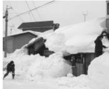
例年になく積雪により屋根の倒壊のおそれがある世帯（材木町地内）
