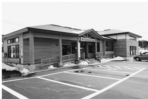
地域産材を使用した郷の杜わきがみ会館
