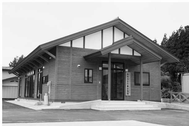
地域産材を利用した桃栄多目的集会施設
