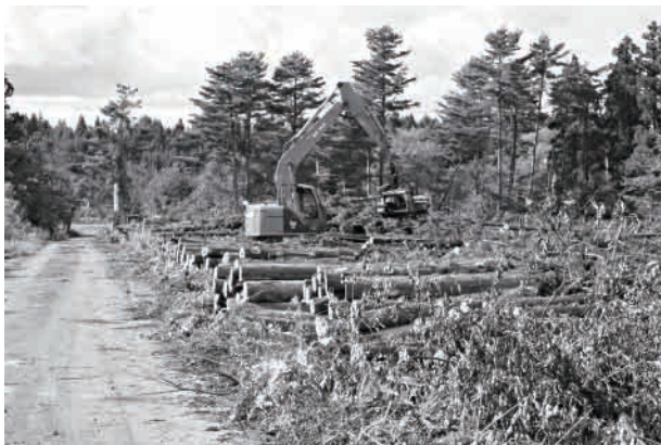
伐採作業が進められている新病院建設地
