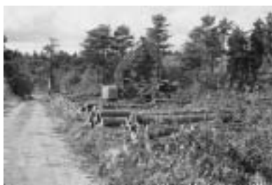
▲北秋田市民病院(仮称)の第1次造成工事
