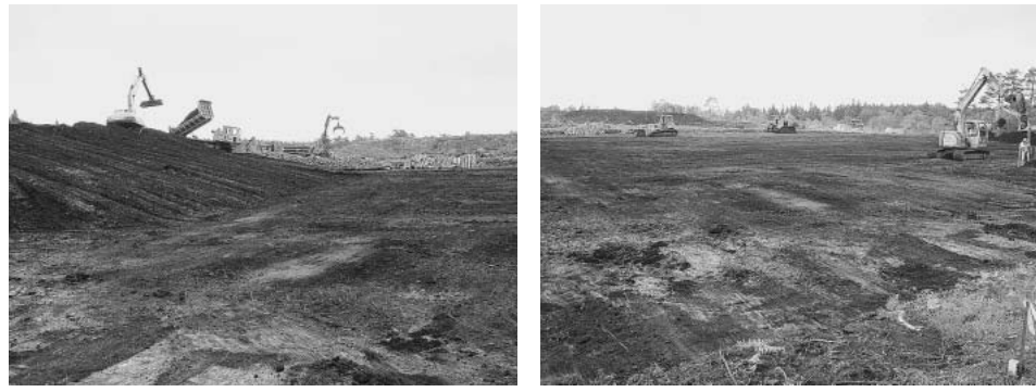
▲9月以降着工する本体工事に向け造成工事が行われている病院建設地
